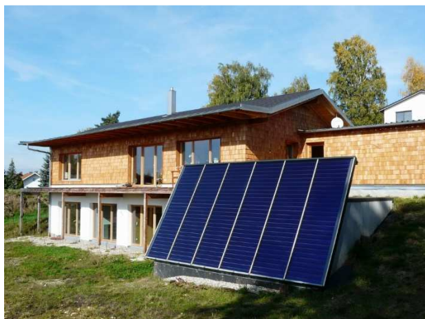
Durch die Hangbauweise konnte der Hochleistungsflächenkollektor mit optimaler Neigung an die Wand des Lagerraums zum UG montiert werden.
