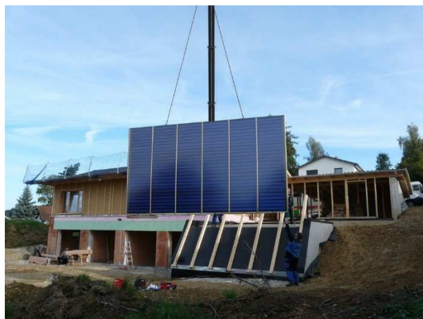
Der Kollektor während der Montage.
