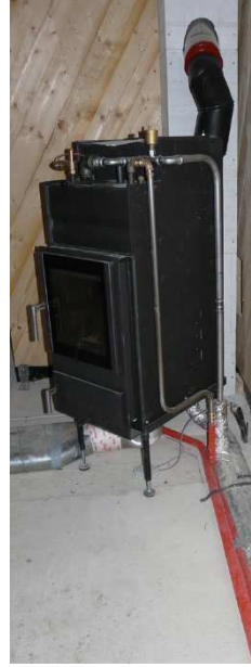
Der POWALL SONNE Heizeinsatz vor und nach der Ummauerung und Gestaltung.
