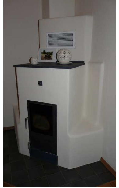
Der POWALL SONNE Heizeinsatz vor und nach der Ummauerung und Gestaltung.
