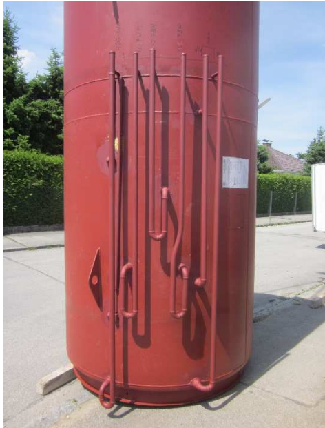
Die Speicherverrohrung wurde vor Ort geschweißt.
