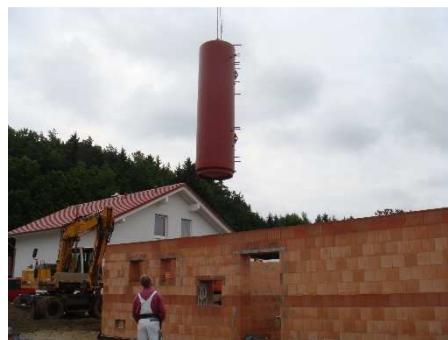
Der 6.300 l fassende Pufferspeicher wurde vor dem Auflegen der Erdgeschossdecke eingebracht.
