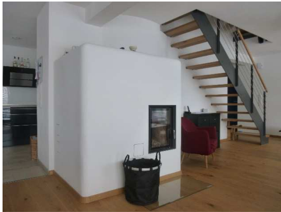
Die einzige Nachheizquelle, der BRUNNER Zentralheizungsofen, ist zentral in der Wohnung angeordnet.
