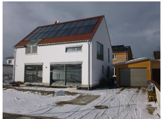
Der ca. 40 m 2 große Hochleistungsflächenkollektor nimmt fast die ganze Dachfläche ein.
