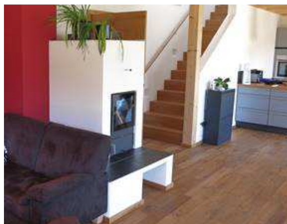
Schön und effizient: Der wasserführende Holz-Zentralheizungsöfen POWALL OFKA hat 25 kW wasserseitige Leistung, raumseitig aber nur 2 kW.
