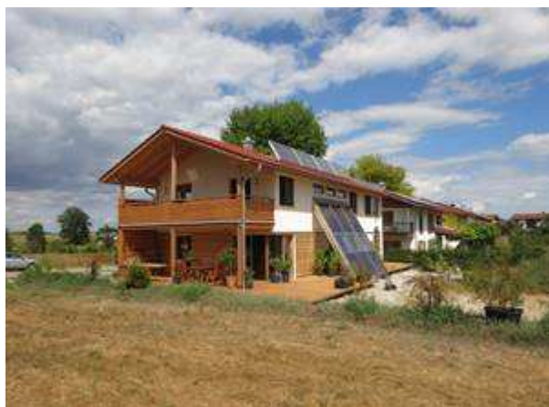
Auf dem Dach sind 4 Querformat-Modulkollektoren aufgeständert montiert, die restliche Kollektorfläche wurde in die Wintergartenkonstruktion integriert.
