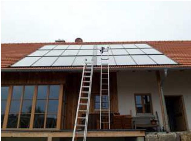
Die Kollektoranlage kurz nach der Montage. Das Kollektorfeld besteht aus 6 HFK-Modulen mit je 8 m<sup>2</sup> Fläche und einem Mitten-Verrohrungskanal.
