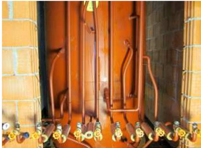
Der 11.000 l SWISS-Solartank vor dem Verschließen der Einhausung. Der komplette Hohlraum wurde mit Einblasdämmung ausgefüllt.
