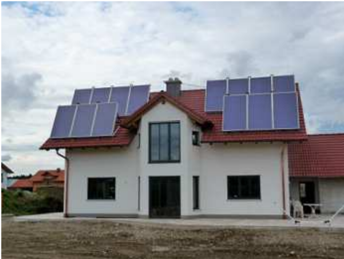
Die Dachneigung ist zu flach, die 14 OmniSol A Kollektormodule wurden daher in 2 x 2 Reihen aufgeständert.
