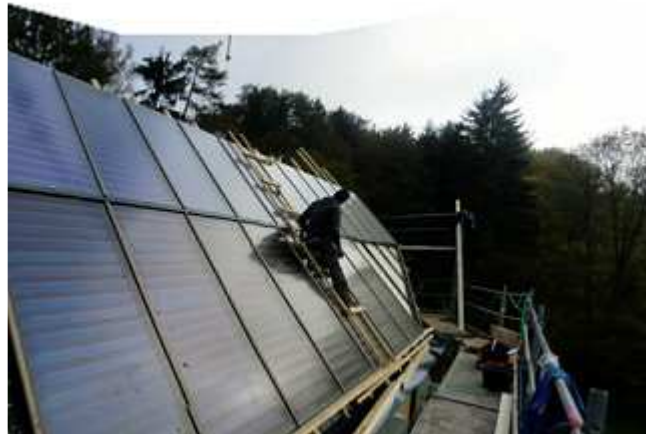
Während der Kollektormontage.
