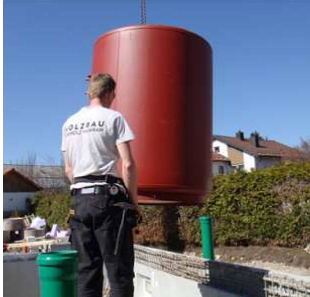
Der ca. 4.000 l fassende Pufferspeicher wurde vor dem Auflegen der Kellerdecke mit dem Baukran eingebracht.
