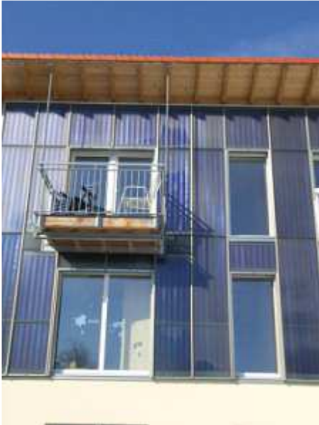
Die verbleibende Südfassade wurde oberhalb des Erdgeschosses komplett als Fassadenkollektor ausgebildet.
