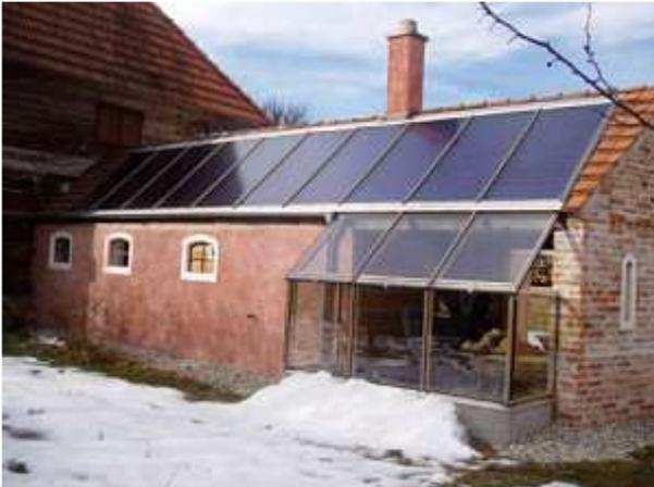
Die Kollektoren sind in einem Winkel von 45 Grad montiert. Das ergibt einen guten Solaretrag im Winterhalbjahr.
