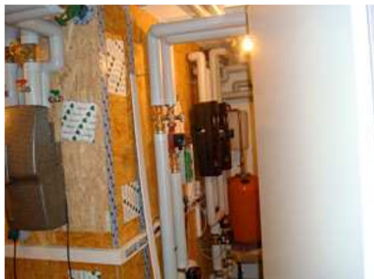
Ein Blick in den noch nicht ganz fertigen Technikraum. Hinter der OSB-Trockenbauwand befindet sich der 11.000 l fassende Pufferspeicher.
