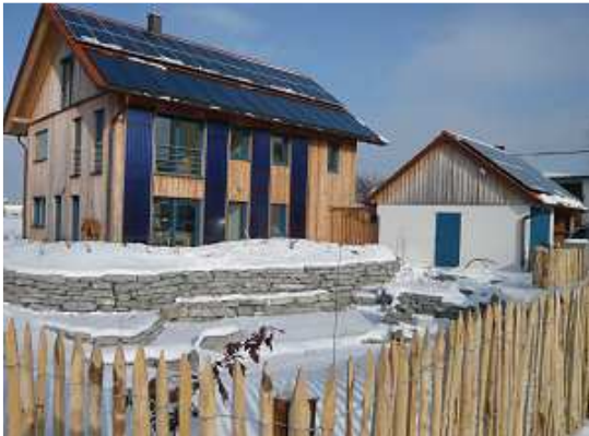
Die maßgeschneiderten Dach- und Fassadenkollektoren fügen sich schön in das Gebäude ein.
