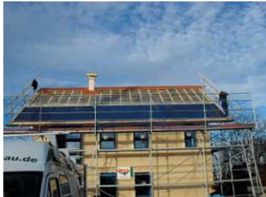
Während der Kollektormontage.
