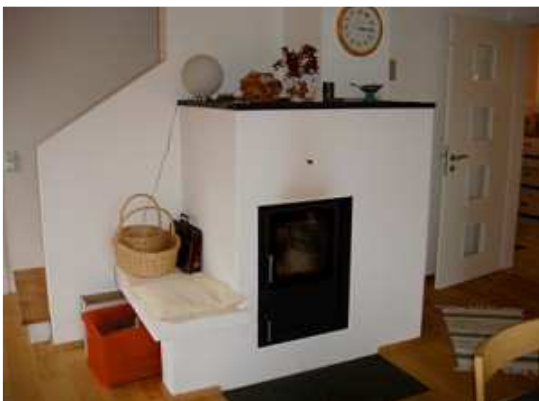
Einzigste Nachheizquelle ist der POWALL OFKA Holz-Zentralheizungsöfen.
