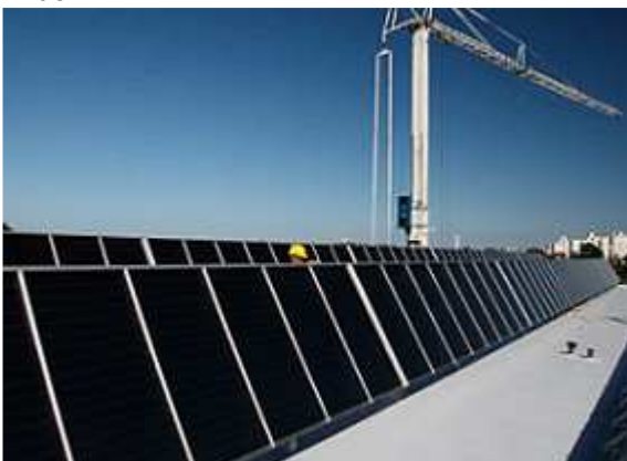
Kollektoranlage XXL: Montage der 368 m 2 Großmodule.
