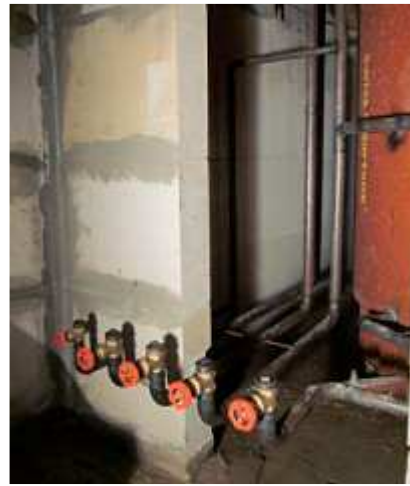
Der zentral im Gebäude stehende Pufferspeicher wurde nach dem Anschweißen der Rohrleitungen eingemauert und mit Einblasdämmung isoliert.
