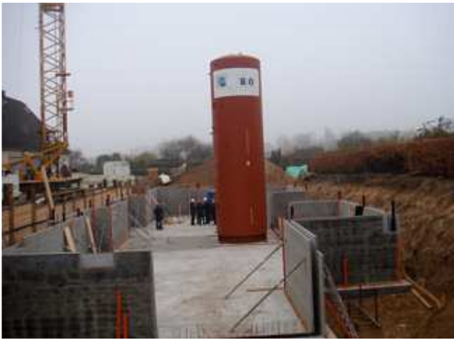
Der 10,5 m hohe Speicher wurde direkt auf die Bodenplatte gestellt.
