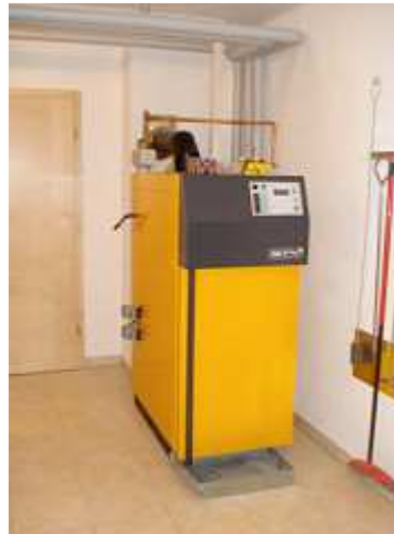
Komfortabel: Der 30 kW ETA Holzvergaserheizkessel hat einen sehr großen Füllraum für Halbmeterscheite.
