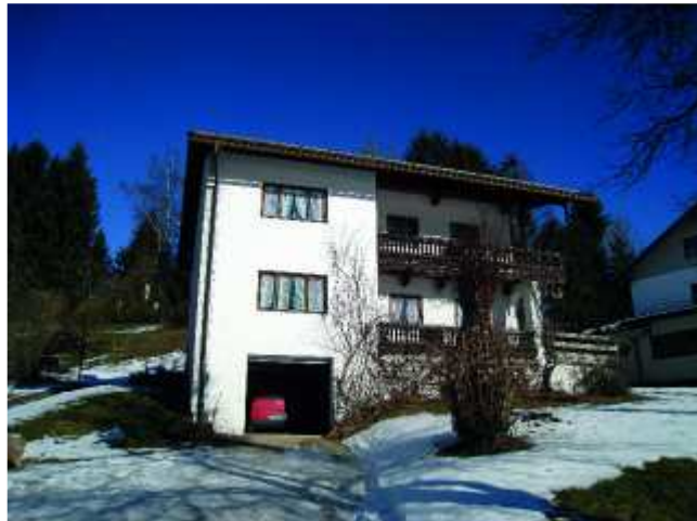
Vorher – nachher: So sah das Wohnhaus Baujahr 1959 vor der Sanierung aus.
