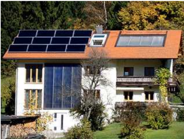
Die Südansicht des sanierten Wohngebäudes mit Anbau auf der Westseite. Rechts auf dem Dach befindet sich eine verschließbare Dachterrasse.
