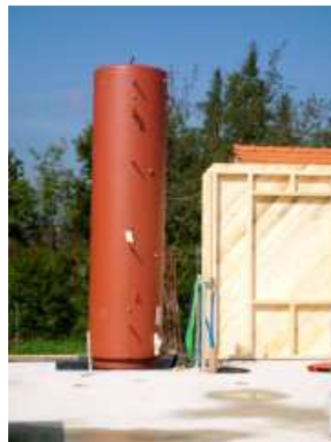
Der ca. 5 m hohe Pufferspeicher wurde auf die Bodenplatte gestellt, bevor das Haus errichtet wurde.
