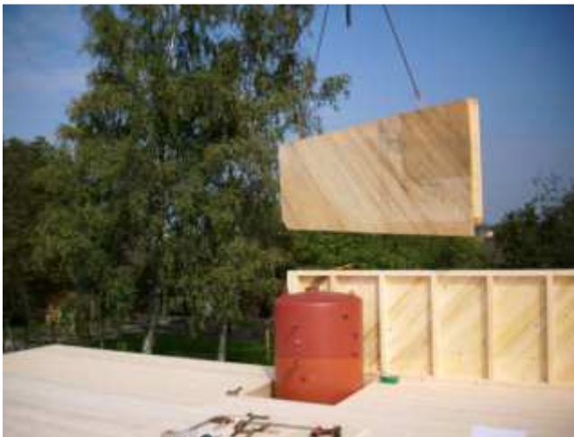
Während des Hausbaus.
