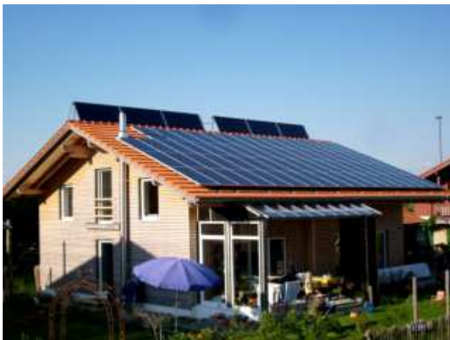
Die 6 Querformat-Kollektormodule wurden hinter dem First aufgestellt. Das flache Süddach ist komplett mit PV-Modulen belegt.
