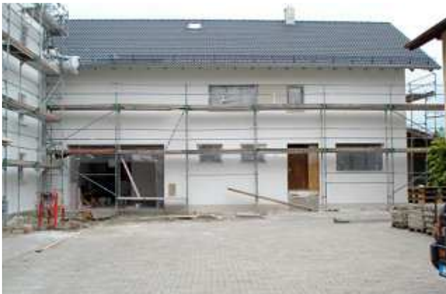
Der im 90° Winkel angebaute Neubau.
