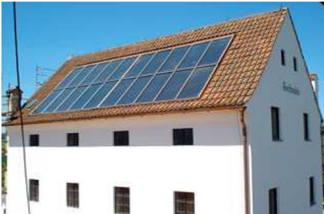
Das alte Mühlengebäude mit optimaler Dachneigung und Südausrichtung.
