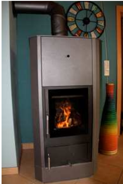
Den gesamte Restwärmebedarf liefert der den POWALL Sonne Zentralheizungs-Kaminofen mit Holzvergasertechnik.
