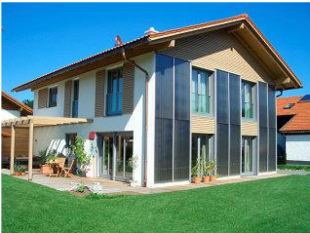
Da das Hausdach zu flach und zudem nicht nach Süden ausgerichtet ist, wurde die Giebelwand mit drei Fassadenkollektorfeldern versehen.
