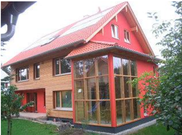
Das 40 m 2 große Kollektorfeld ist auf zwei Hälften mit je 20 m 2 aufgeteilt. Durch die moderne Farbgebung und äußere Gestaltung ist der Altbau nicht wieder zu erkennen.
