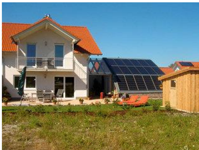
Das neue Eigenheim aus der Südperspektive. Die Dachneigung ist für solares Heizen mit hohem Deckungsanteil zu flach, kann aber für Photovoltaik genutzt werden.
