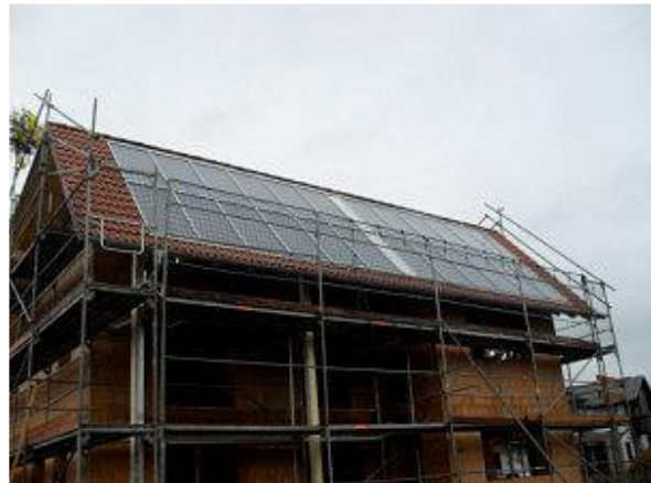
Eine Aufnahme während der Bauphase.
