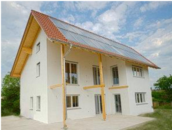
Der 48 m 2 große dachintegrierte Hochleistungsflächenkollektor Typ HFK nimmt den Großteil der Süddachfläche ein.
