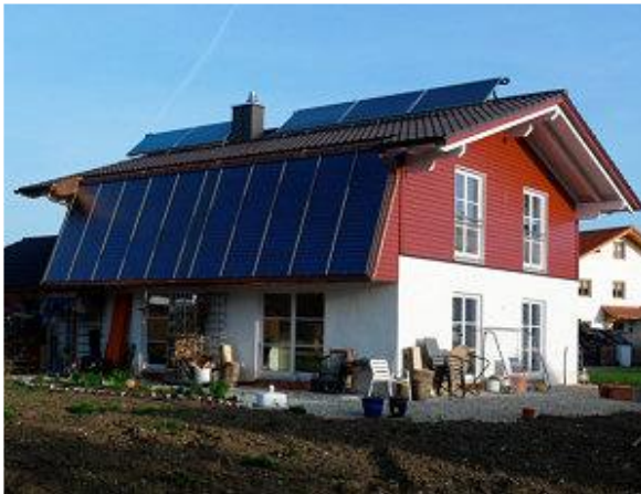
Nicht alltägliche Konstruktion: Der 31 m 2 große Hochleistungsflächenkollektor wurde mit steiler Neigung an die Fassaden angesetzt.
