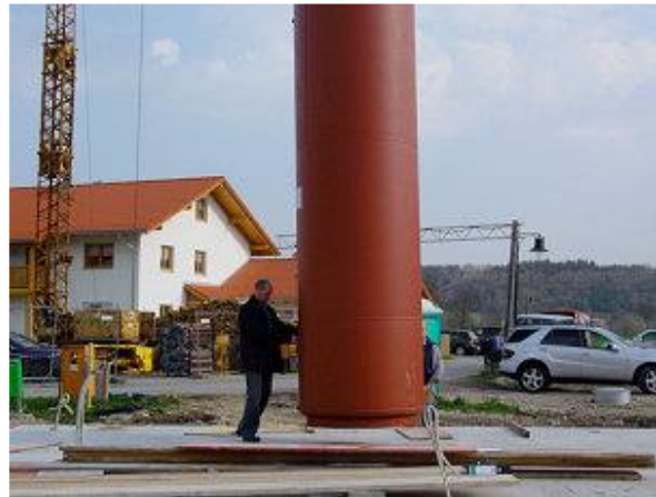
Vor dem Aufbau des Holzhauses wurde der Speicher in die Aussparung der Kellerdecke eingebracht. Der knapp 5 Meter hohe Pufferspeicher reicht bis zur Unterkante der Obergeschossdecke.
