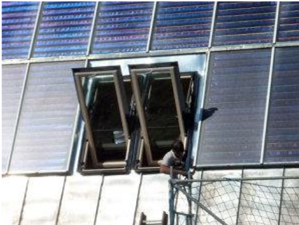
Die Dachfenster wurden in die Großflächenkollektoren integriert.
