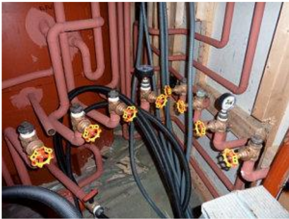
Die komplette Pufferverrohrung wurde mit nahtlosem Stahlrohr geschweißt, als Absperrarmaturen kamen nur langlebige Rot-Gelb-Schieber zum Einsatz.
