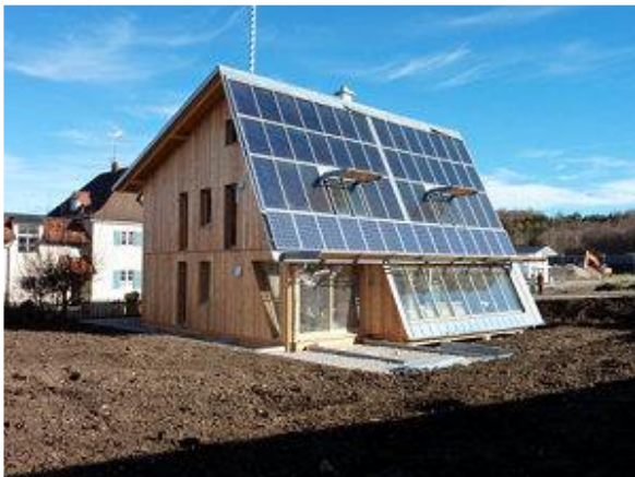
Das Bio-Sonnenhaus in Inning am Ammersee ist in jeder Hinsicht konsequent und außergewöhnlich.
