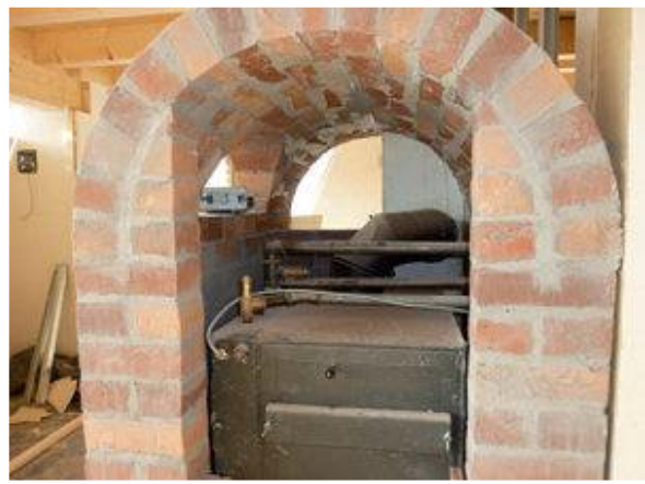
Der POWALL Vario K Ofeneinsatz während der Ofensetzerarbeiten.
