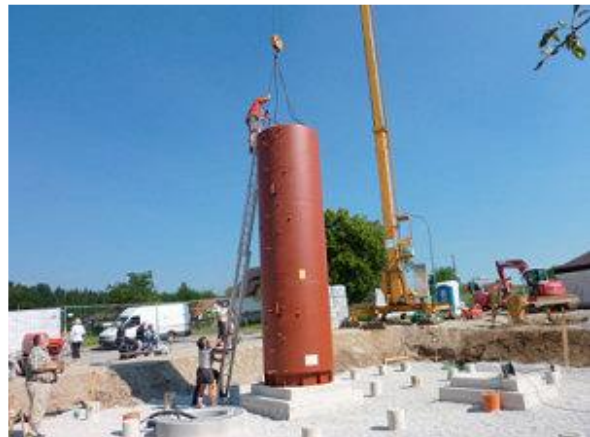
Der 14.000 l SWISS-SOLARTANK wurde vor Aufstellen des Holzhauses auf den Betonsockel gestellt.
