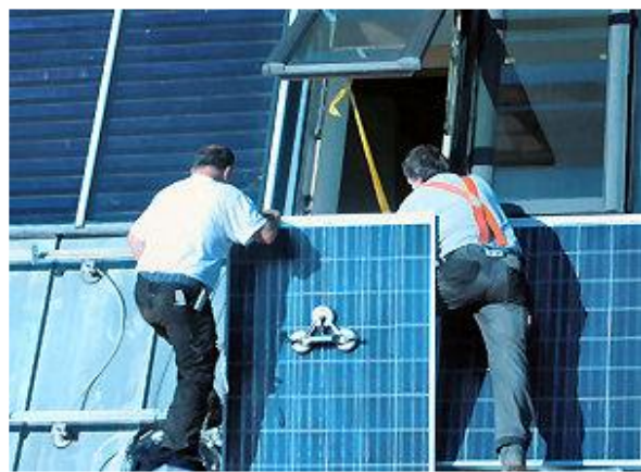
Die Montage der Solarstrom-Module.
