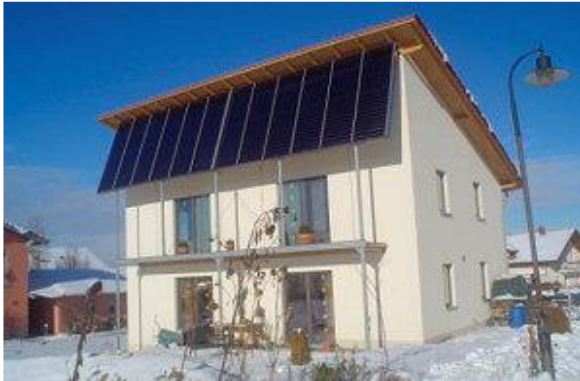
Konsequente Solararchitektur: Kompakter Baukörper, Pultdach und vorne steil angestzter Kollektor.
