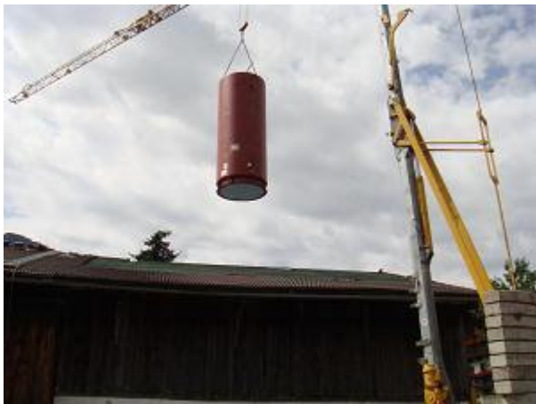
Zum Einbringen des Pufferspeichers wurde das Dach des Heustadls geöffnet.
