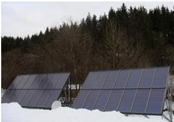
Da wegen des Denkmalschutzes eine Montage des Kollektors auf dem Hausdach nicht möglich war, wurde die Anlage hinter dem PKW-Stellplatz mit 60° Neigung frei aufgestellt. Der Kollektor ist von aussen nicht einsehbar.
