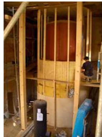
Der Speicher wurde vor Ort mit einer Trockenbau-Einhausung verkleidet und gedämmt.
