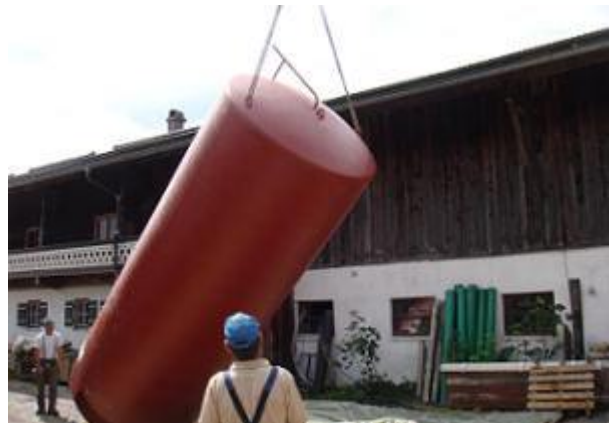
Der 15.100 l Jenni-Pufferspeicher wurde per LKW angeliefert und mit Hilfe eines Krans in das Gebäude eingehoben.
