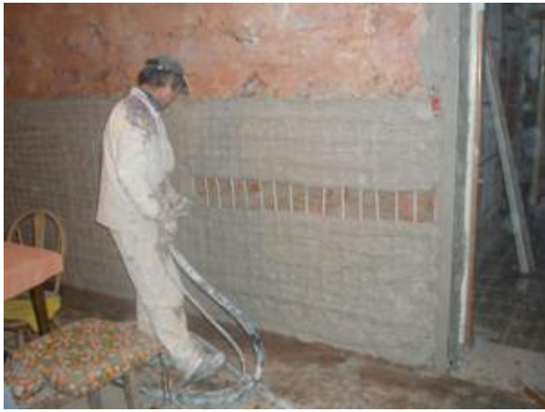
Verputzen der Wandheizung in der Gaststube.
