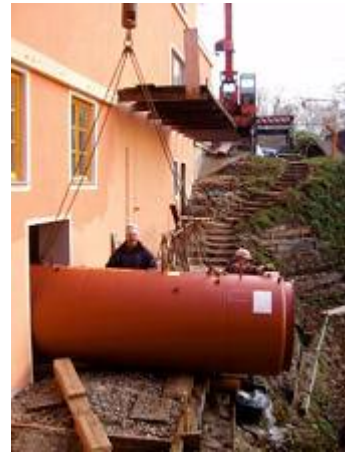
Das Runde muss ins Eckige - Einbringen des Jenni-Speichers am Inn-Steilufer.
