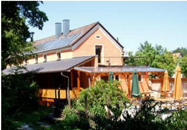
Das schicke Terrassencafe im fertigen Zustand. Die Sanierung mit viel Eigenleistung war recht aufwändig.
