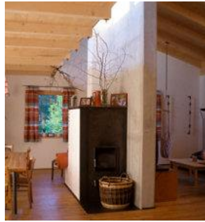
Einzigste Nachheizquelle ist der im Wohnraum stehende POWALL OFKA Holz-Zentralheizungsöfen.
