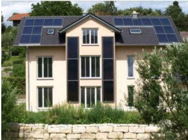
Die 48 m 2 Kollektorfläche beim Sonnenhaus Zellner wurden auf Dach und Fassade verteilt.
