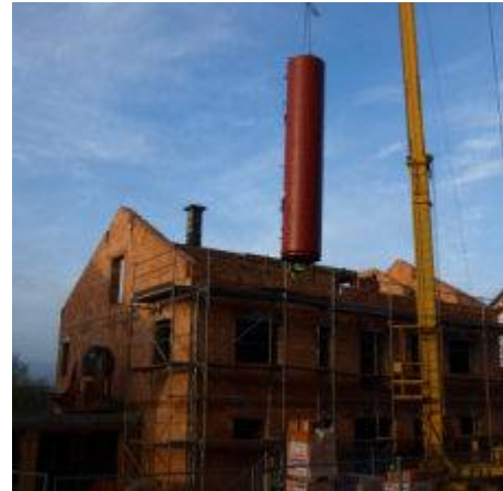
Die Einbringung des Großspeichers war – wie so häufig – ein wahres Spektakel.
