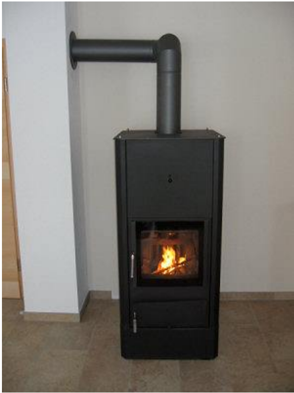
Heizkessel im Wohnzimmer: Im POWALL SONNE steckt die Technik eines Holzvergaser-Heizkessels mit ca. 20 kW Nennwärmeleistung.
