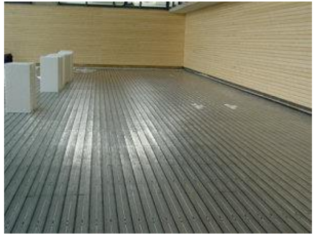
Verlegung der Sportbodenheizung.
