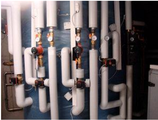
Einer der beiden ca. 5.000 Liter Pufferspeichern mit Verrohrung und Armaturen direkt am Speicher.
