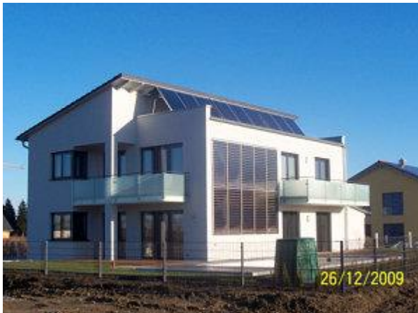
Das Sonnenhaus weist eine sehr moderne Architektur auf.
