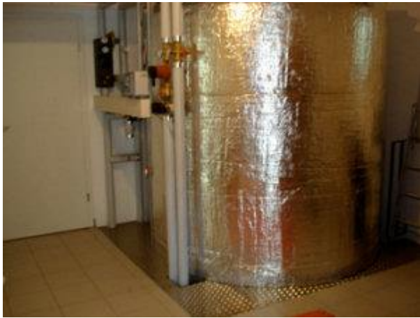
Der 3,50 m hohe Pufferspeicher mit 1,70 m Durchmesser (zuzüglich Wärmedämmung) wurde 1,50 m in die Bodenplatte versenkt.
