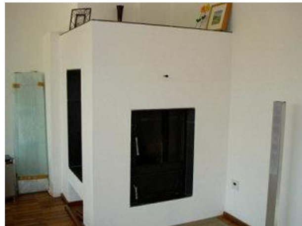
Die Nachheizung erfolgt vom Wohnraum aus mit einem POWALL OFKA Zentralheizungs-Holzofen.
