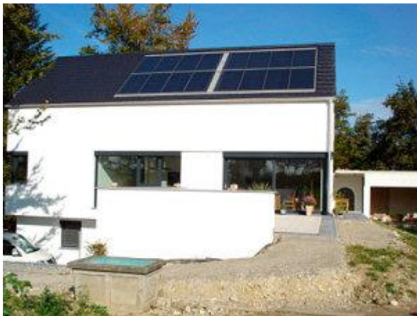
Der 32 m 2 große Hochleistungsflächenkollektor mit Mitten-Verrohrungskanal fügt sich schön in die Dachfläche ein.
