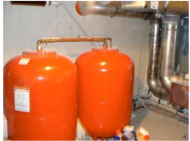
Die Lüftungsanlage mit Wärmerückgewinnung ist zusätzlich mit einem Erdrohr-Wärmetauscher zur Luftvorwärmung ausgestattet.
