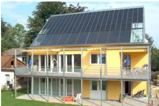
Konsequente Solararchitektur: Der Solarkollektor und der verglaste Dachüberstand sind als eine Einheit gefertigt. Auf der kompletten Süd- und Norddachhälfte dient eine Dünnschicht-
