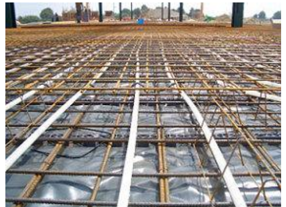
Rohre, so weit das Auge reicht: Über 120 km PEX-Rohr wurden in der ersten Ausbaustufe verlegt.
