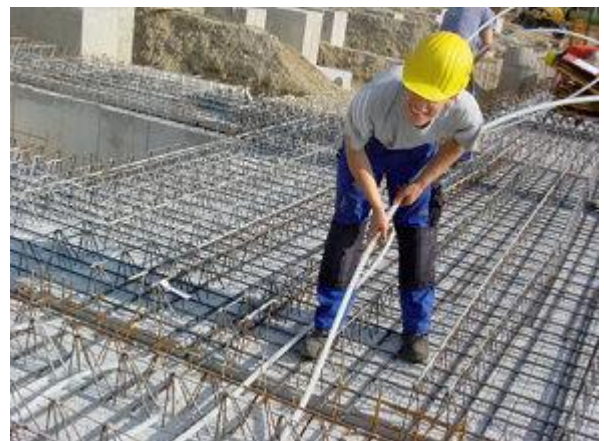
In den Obergeschossen mussten die Rohre sehr aufwendig
