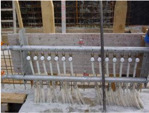
Die Industrieverteiler aus 2" Edelstahlrohr wurden in den eigenen Werkstätten von Fa. Schletter gefertigt.
