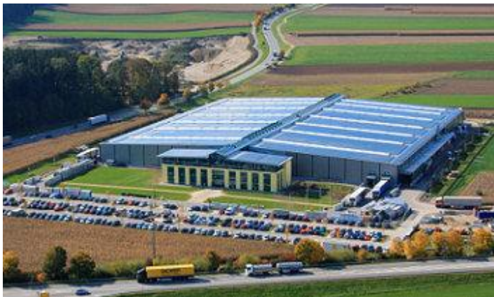
Büro und Produktionshallen der Fa. Schletter – mittlerweile entsteht der nächste Bauabschnitt.
