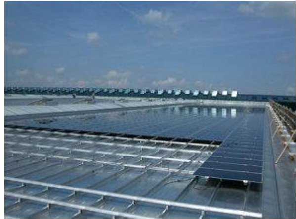
Klar, dass Fa. Schletter als einer der führenden Hersteller von PV-Montagesystemen eine eigene Solarstromanlage hat. Die flach aufgeständerte Anlage hat eine Leistung von ca. 1,3 MWp.
