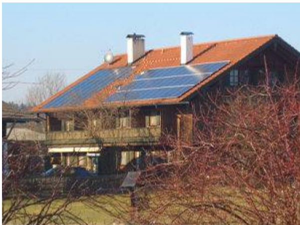
Um das exakt nach Süden ausgerichtete und 30° steile Dach optimal energetisch zu nutzen, wurde neben der Kollektoranlage noch eine 6,3 kWp Photovoltaikanlage installiert.
