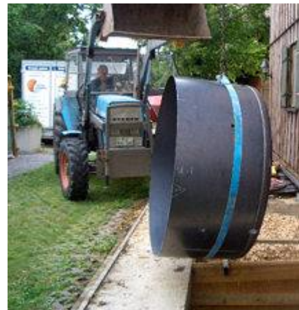
Die beiden SWISS-SOLAR Pufferspeicher wurden zur Einbringung in Teilen geliefert und vor Ort geschweißt.
