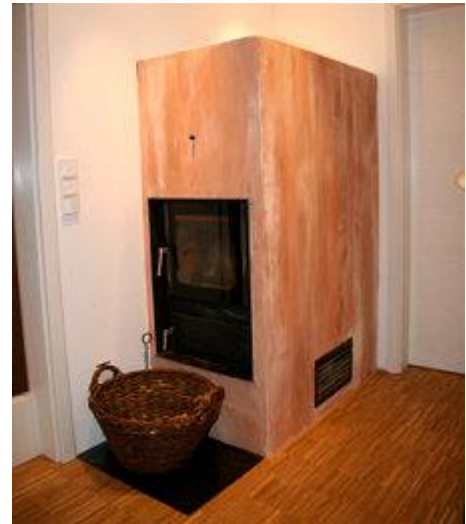
Der überschaubare Restenergiebedarf wird ausschließlich durch den POWALL Holz-Zentralheizungsöfen abgedeckt. Der Ofen ist wie eine Skulptur im Gang positioniert.
