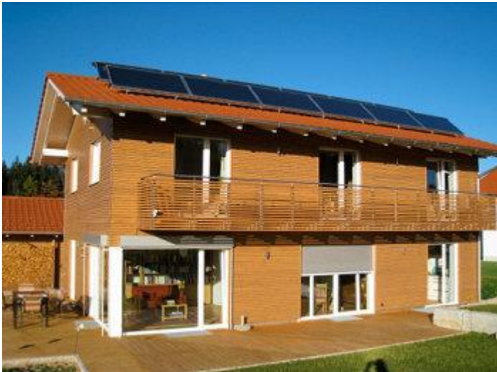
Die waagrecht verlaufende Holzverschalung verleiht dem schicken Haus einen sehr modernen Charakter. Da die Dachneigung nur 21° beträgt, wurde die Kollektoranlage in zwei Reihen auf 41° aufgeständert.
