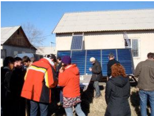
Solaranlagenbaukurs in Bishkek, Kirgistan.
