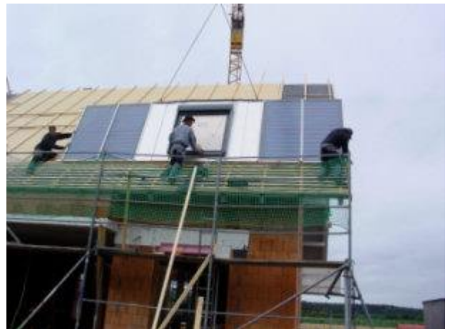
Rationell: Die Dachfenster wurden samt Eindeckrahmen in das Kollektormodul integriert und per Kran montiert.
