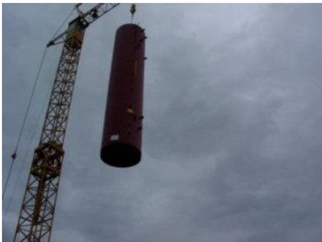
Mit Hilfe eines Krans wurde der Speicher über das Dach eingehoben.
