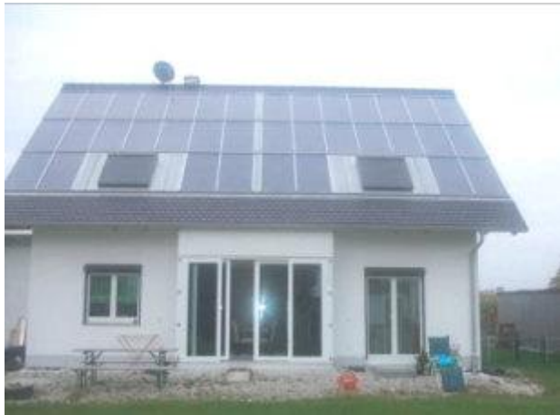
Der dachintegrierte Hochleistungsflächenkollektor belegt fast die komplette Süd-Dachhälfte.
