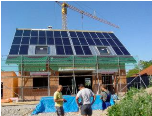
Als gelernter Spengler hat Bauherr Florian Kapsegger die Kollektoranlage mit viel Eigenleistung montiert.
