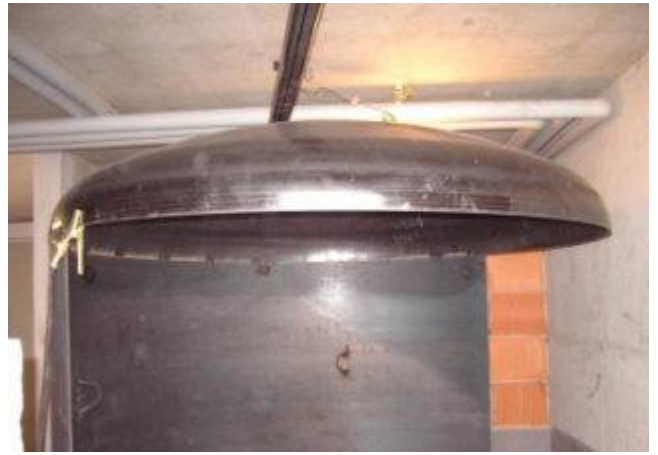
Der Pufferspeicher mit 1,90 m Durchmesser und ca. 5,20 m Höhe wurde komplett in Eigenleistung gefertigt.
