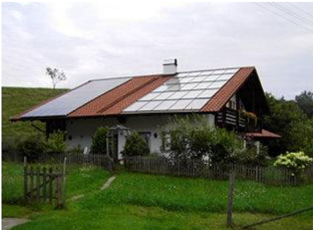
Rechts der 47,5 m 2 Hochleistungsflächenkollektor, die Photovoltaikanlage wurde bereits 2001 installiert.
