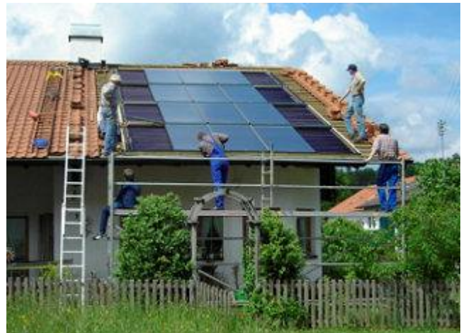
Die Kollektoranlage wurde komplett in Eigenleistung gebaut.
