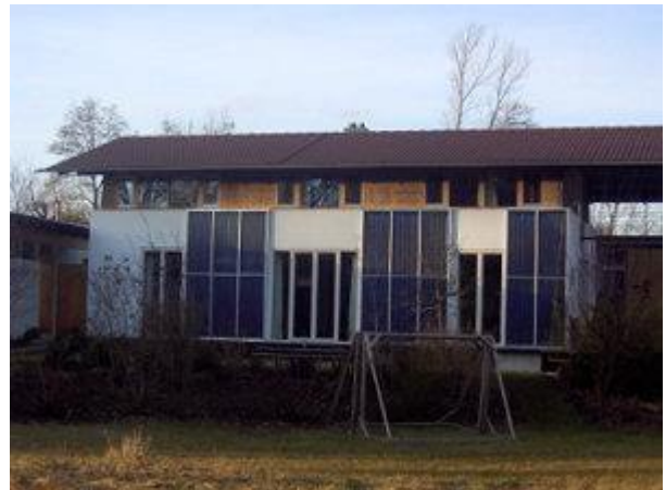
Ein Blick auf die Südseite: Die 24 m 2 Fassadenkollektoranlage besteht aus drei maßgeschneiderten Teilflächen.
