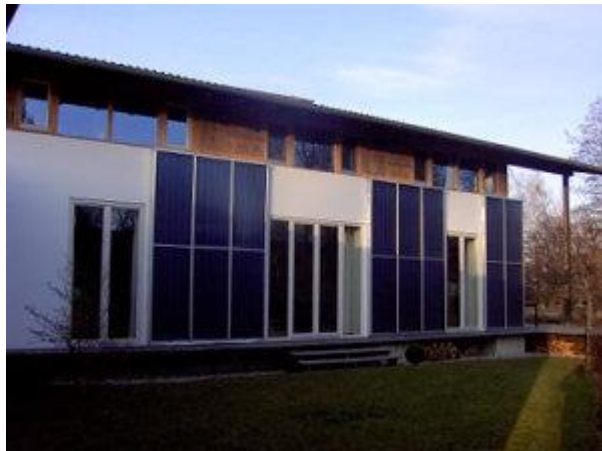
Fassadenkollektoren gewinnen immer mehr an Bedeutung. Diese Anlage fügt sich architektonisch sehr schön in das Gebäude ein.
