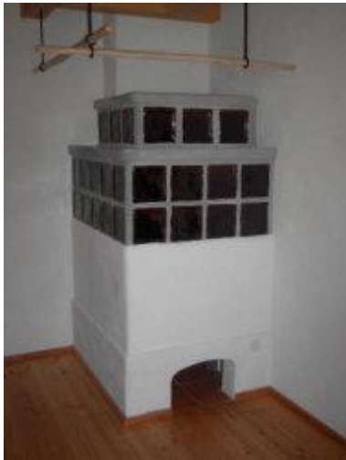
Der POWALL-Heizeinsatz ist auf der Wohnzimmerseite mit einem schönen und traditionell gestalteten Kachelofenkörper ummauert.
