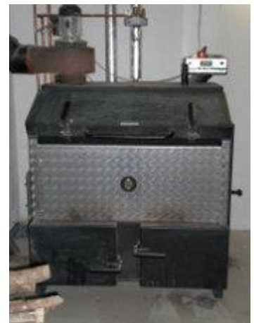
Im LOPPER DRUMMER Holzvergaserheizkessel haben Meterscheite Platz.
