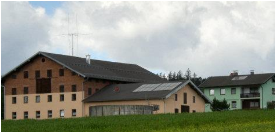
Der ehemalige Stall wurde mit einer großzügigen Wohnung ausgebaut. Die Kollektoranlage: 32 m 2 auf der Maschinenhalle, 6 m 2 auf dem alten Wohnhaus.
