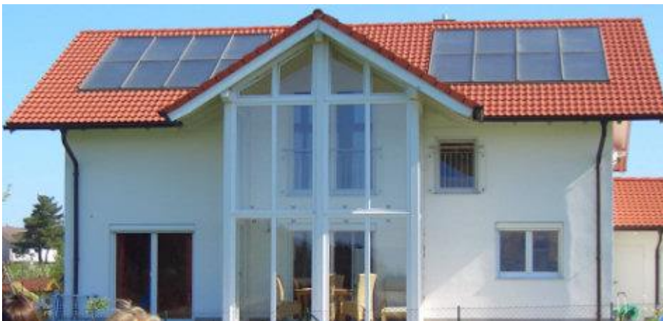
Die 32 m 2 Kollektoranlage ist in zwei Felder mit je 4 x 4 m aufgeteilt. Eine steilere Dachneigung wäre allerdings von Vorteil.
