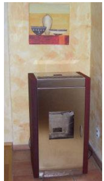
Der Zentralheizungs-Pelletofen begnügt sich mit 1,5 Tonnen im Jahr.
