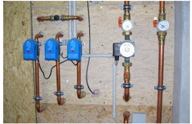
Motorkugelhähne zur Zuschaltung einzelner Speicher
