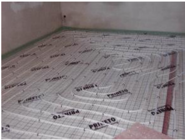
Das niedrige Temperaturniveau der Heizflächen (hier Fußbodenheizung vor der Estrichbringung) macht die Solaranlage effizienter
