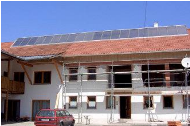
Eine ausreichende Kollektorneigung wurde durch eine so genannten Firstverlängerung ermöglicht
