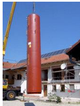
Der 8000 l Speicher wurde mit Hilfe eines Autokrans eingebracht
