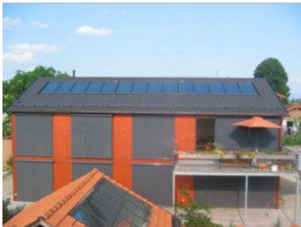
Die Kollektorfläche beträgt 28 m 2 . Auffällig sind die außenliegenden Verschattungsanlagen.
