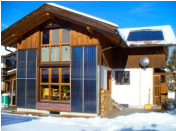
Der Fassaden- und der Dachkollektor können unabhängig voneinander angesteuert und betrieben werden.
