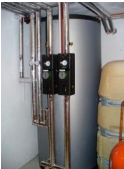
Der Fassaden- und der Dachkollektor können unabhängig voneinander angesteuert und betrieben werden.
