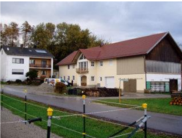
Links das alte Wohnhaus mit separater 6 m 2 Kollektoranlage, rechts des ausgebaute Stadel.
