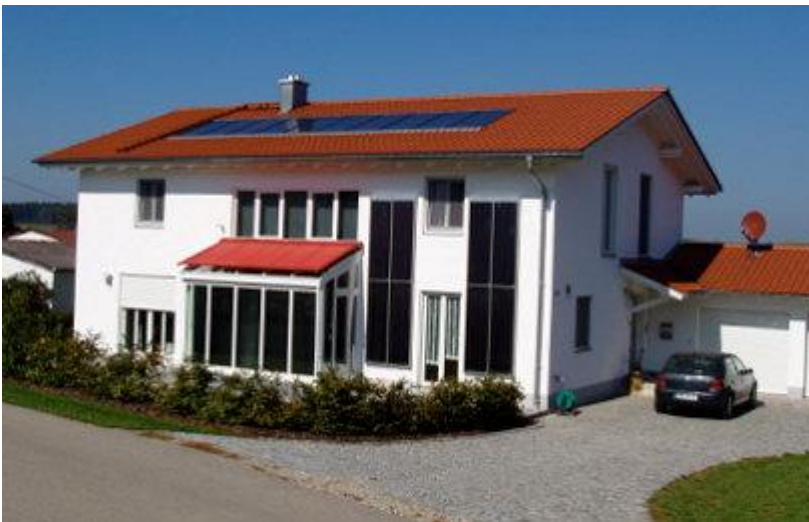
Aus einem Guss: 20 m 2 Hochleistungsflächenkollektor auf dem Dach und 10 m 2 in der Fassade sind sauber integriert.
