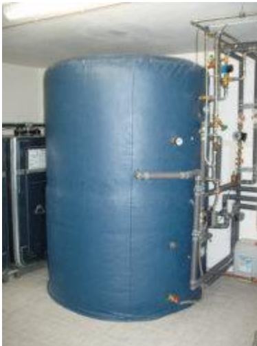
Ein Blick in den Technikraum: Der SWISS-SOLAR-Kombispeicher hat ca. 2.640 l Gesamtvolumen.
