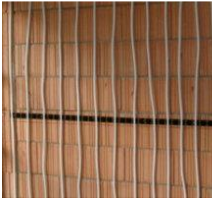
Die Wandheizungsrohre wurden größtenteils in Eigenleistung verlegt.
