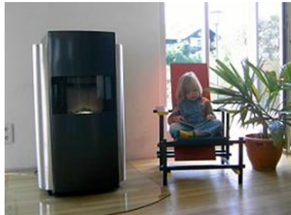
Der Restwärmebedarf wird durch einen im Wohnraum stehenden Pellet-Zentralheizungsöfen gedeckt.
