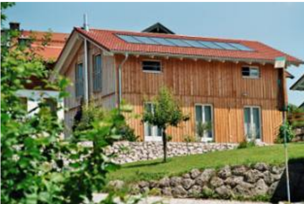
16 m 2 Hochleistungsflächenkollektor auf dem Süddach.
