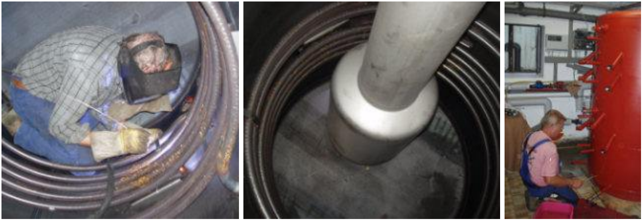
Einbringen und Platzschweißung des neuen Kombispeichers
