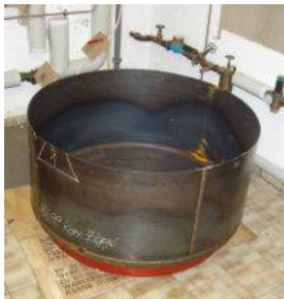
Bergmännischer Abbau: Demontage des 16.000 l Pufferspeichers
