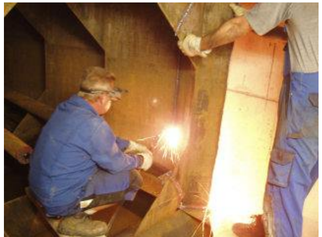
Bergmännischer Abbau: Demontage des 16.000 l Pufferspeichers
