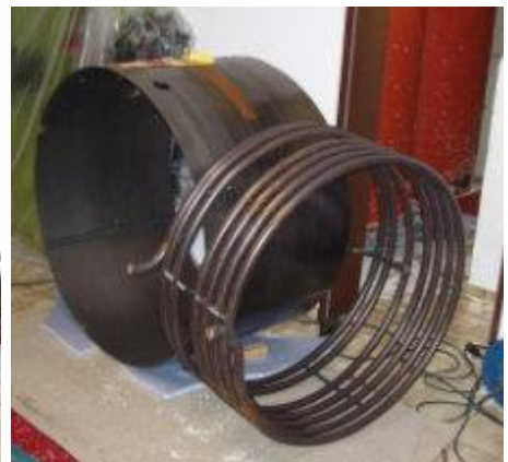
Bergmännischer Abbau: Demontage des 16.000 l Pufferspeichers
