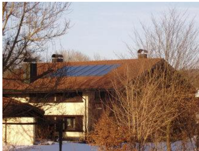
Der 28 m 2 Hochleistungsflächenkollektor auf dem Süddach
