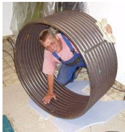
Bergmännischer Abbau: Demontage des 16.000 l Pufferspeichers
