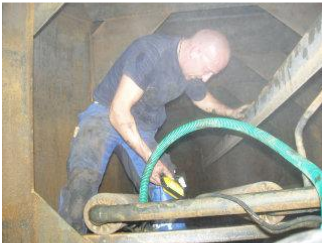
Bergmännischer Abbau: Demontage des 16.000 l Pufferspeichers
